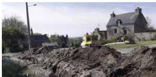
Le CM valide : L'éclairage public : Dépose des foyers existants, confection de 250 ml de tranchée EP, construction d'un réseau souterrain, fourniture et pose de 33 coffrets de raccordement, de 33 lanternes, de 26 mâts et d'1 commande EP. Le montant des travaux s'élève à 134 784 € TTC, dont 78 624 € à la charge de la commune. Le réseau téléphonique : Réalisation de 179 ml de tranchées Télécom indépendantes, réalisation de 1 171 ml de tranchées Télécom supplémentaires en commun avec la tranchée
